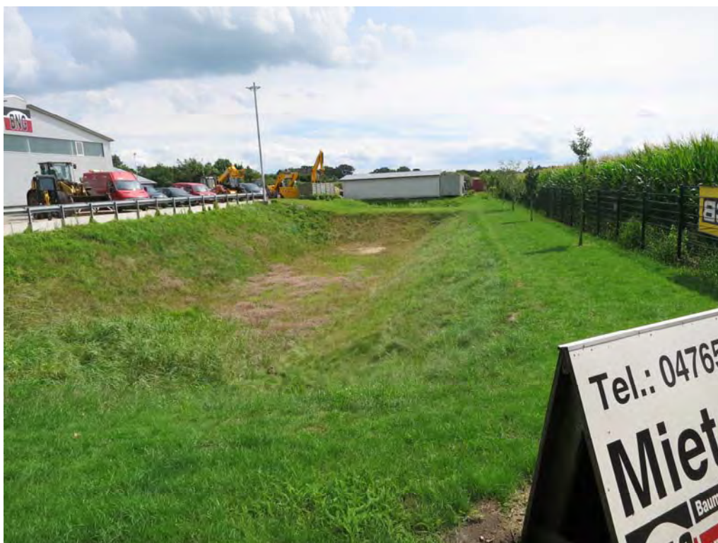
Abbildung 3: Blick von Westen auf das fertiggestellte Regenrückhaltebecken, rechts daneben die Einzelbaumpflanzungen
